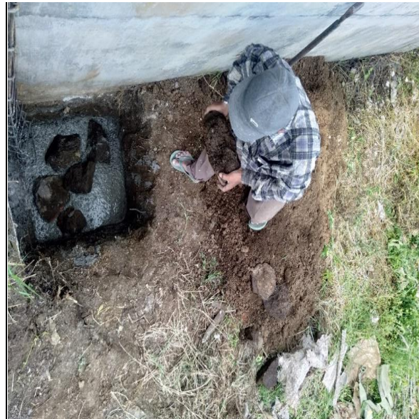
Gambar 4. Pengecoran pondasi cakar ayam pagar pengaman
