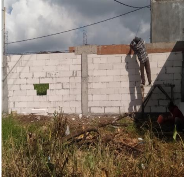
Gambar 5. KeiPemasangan dinding bata ringan
