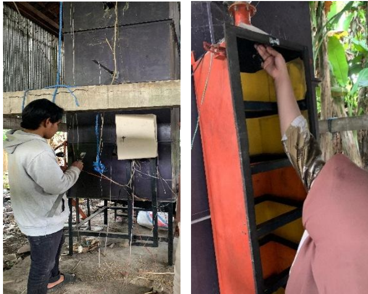
Gambar 6. Instalasi Sistem di Mesin Pengering Tipe Vertikal
